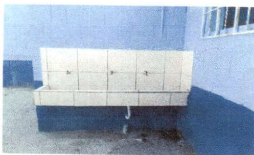
Foto 3: Colocación de lavamanos de
