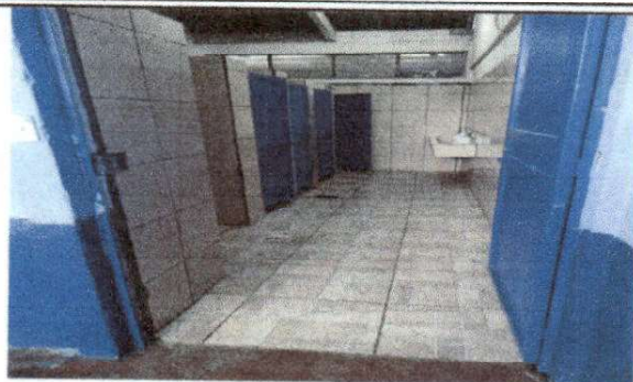
Foto 1: Trabajo finalizado baño de niños cerámico y puertas
