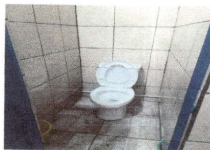
Foto 4: Colocación de inodoros
