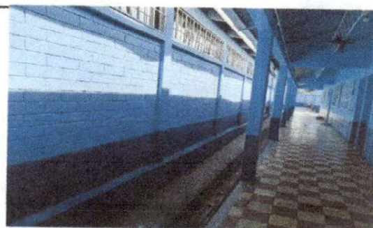
Foto 6: Pintura de pasillos
