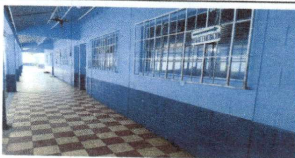
Foto 5: Pintura de corredores
